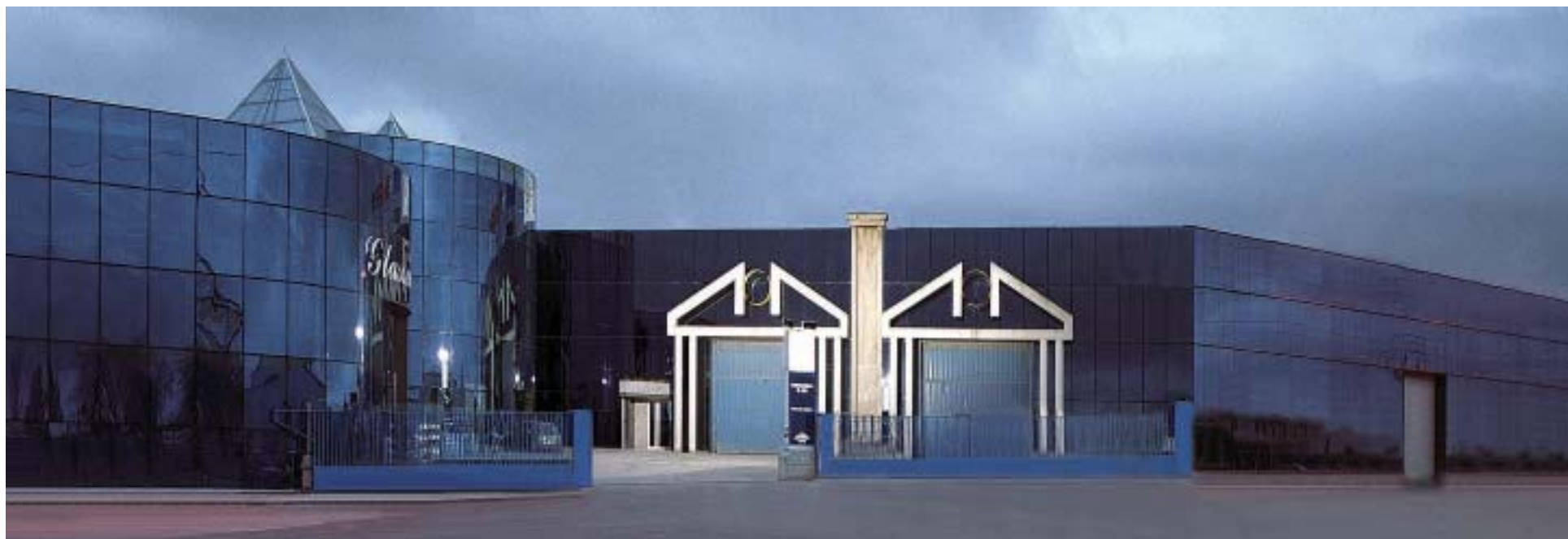
EN VILLALBILLA. CRISTALERÍAS EL CID, DELEGACIÓN DEL GRUPO CORBALÁN EN LA ZONA NORTE, POSEE UNAS MODERNAS INSTALACIONES DE 7.500 M2. / DB
